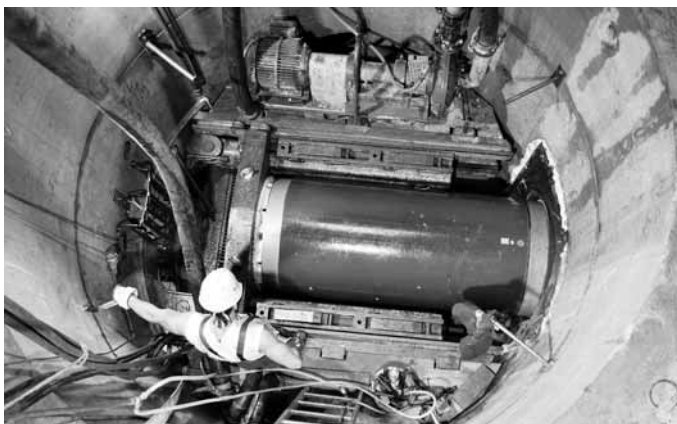
■ Abb. 2: Zur Besichtigung der Berliner Baustellen gehörte auch das Bauvorhaben Hultschiner Damm, Hauptsammler II in Berlin Marzahn/Hellersdorf. Hier werden 1.075 m Schmutzwasserkanal DN 800 bis DN 200 in Berliner Bauweise errichtet. Links: Stahlbetonschacht DN 3200 mit Steinzeugvortriebsrohr DN 800 und Pressschlitten; rechts: Zielschacht und Ausbauvortriebsmaschine (Quelle: Messe Berlin GmbH)
