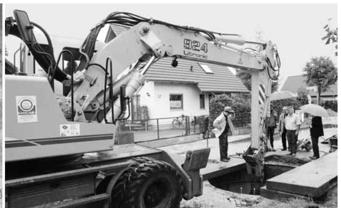
■ Abb. 2: Zur Besichtigung der Berliner Baustellen gehörte auch das Bauvorhaben Hultschiner Damm, Hauptsammler II in Berlin Marzahn/Hellersdorf. Hier werden 1.075 m Schmutzwasserkanal DN 800 bis DN 200 in Berliner Bauweise errichtet. Links: Stahlbetonschacht DN 3200 mit Steinzeugvortriebsrohr DN 800 und Pressschlitten; rechts: Zielschacht und Ausbauvortriebsmaschine (Quelle: Messe Berlin GmbH)
